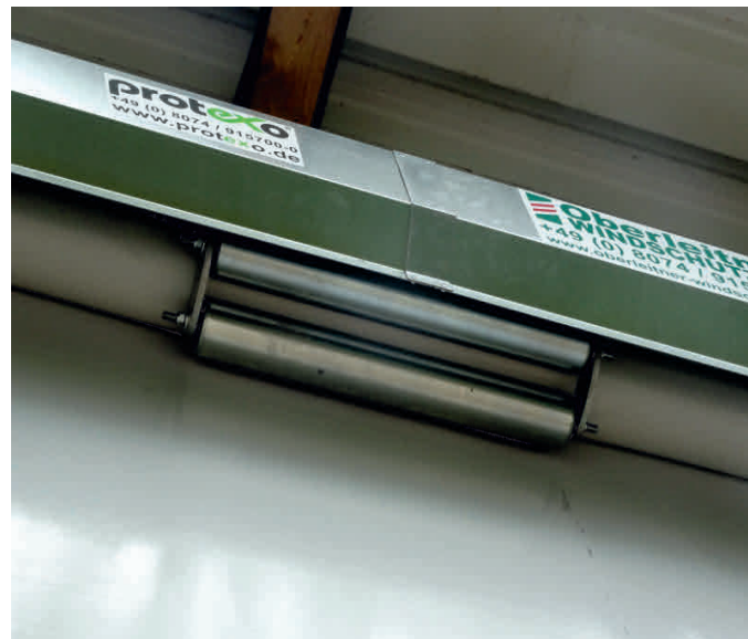
Wellenhalter für gute Planenspannung bei sehr breiten Toren
