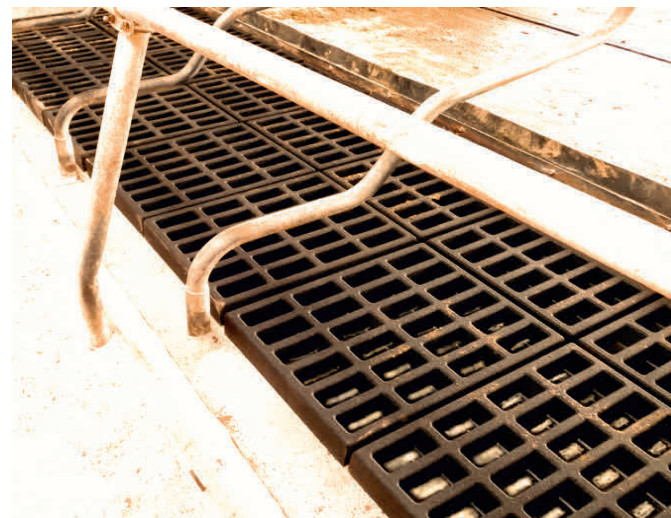
Die Waben werden schwimmend eingelegt
