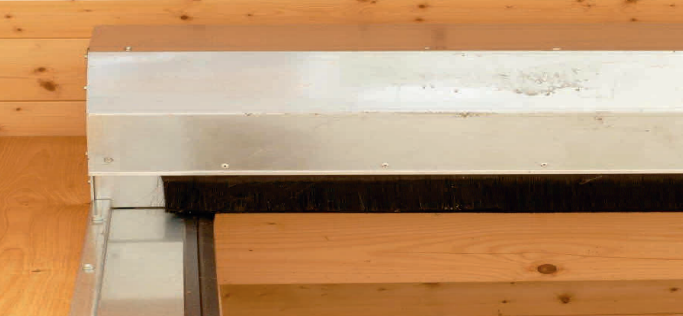
Verlängerte Blechabdeckung mit Bürste gegen Zugluft (oben)
