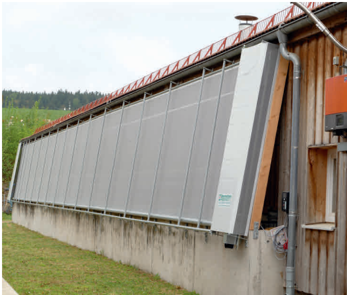
Schrägaufbau mit Sonderwinkeln im Altbaubestand
