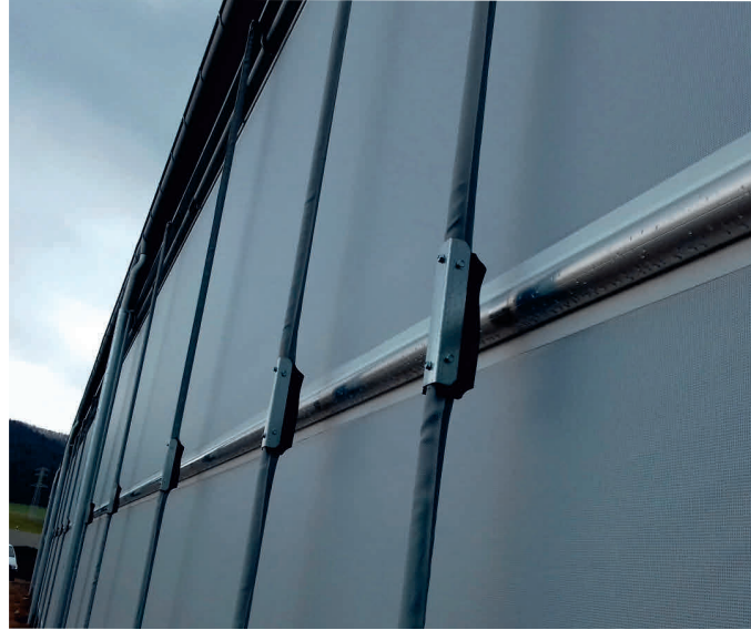
Sonderfall Mittelwicklung des C78 Systems
