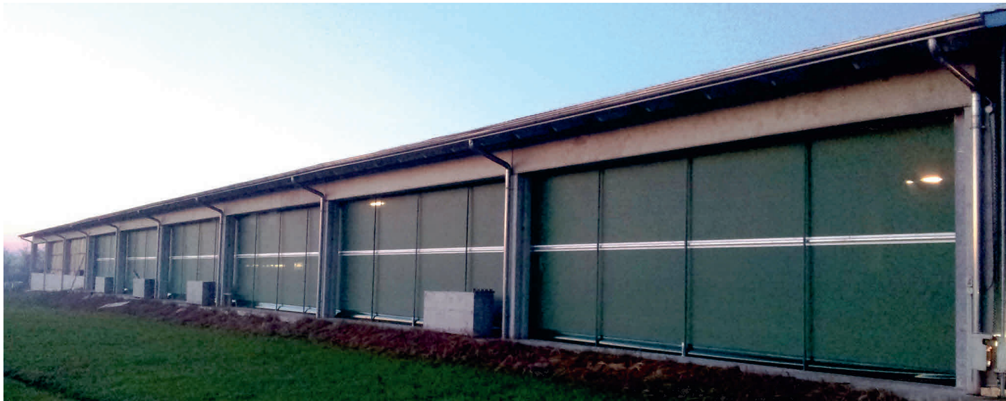
Stallgebäude mit System A mit Mittelwicklung im Innenaufbau - durchgehend mit grünem Netz ausgestattet
