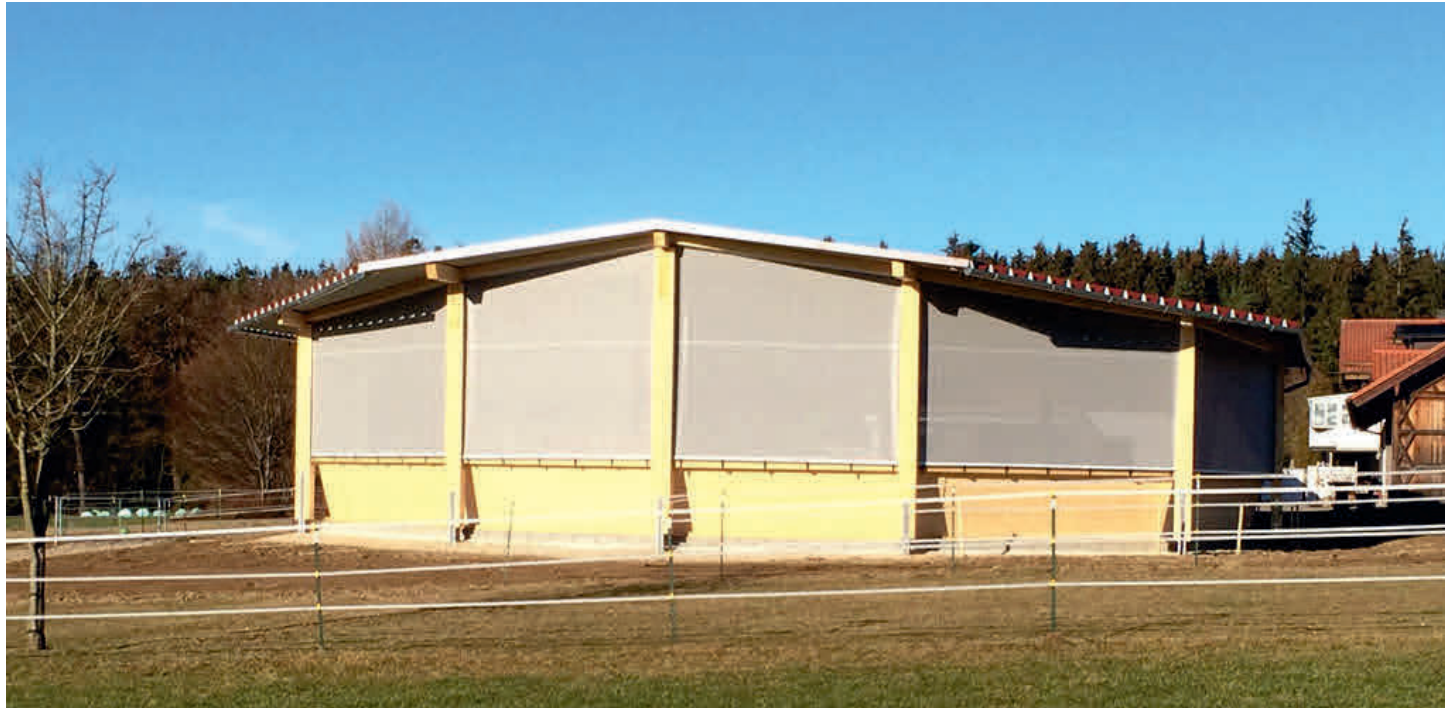
Reithalle mit grauen Netzpaneelen senkrecht verspannt mit wechselnd schrägen Dachlinien rund ums Gebäude
