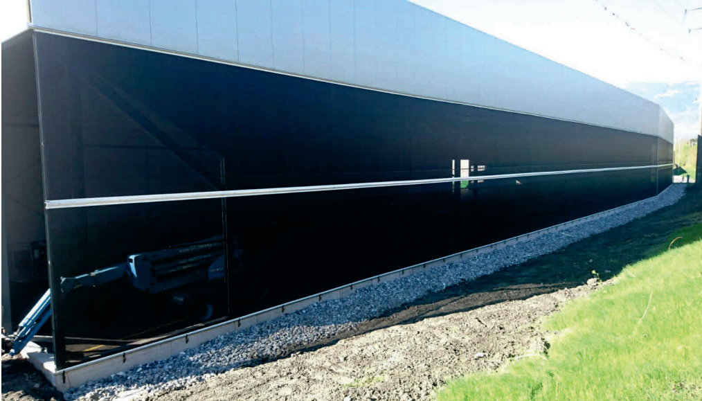
Schwarzes Netzpaneel mit mittigem Doppelkederprofil an einer Holzlagerhalle
