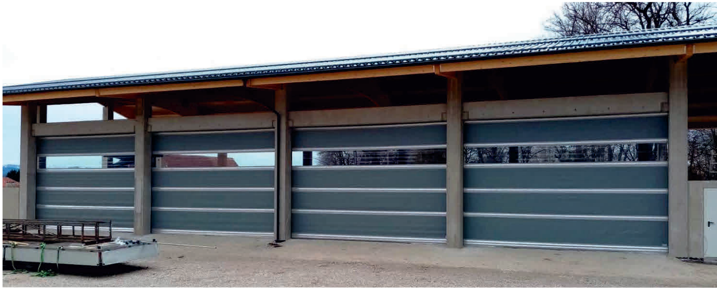
Dezenter Inneneinbau. Die Innenmontage gestaltet sich bezüglich der notwendigen verschiebbaren Aussteifung aufwändiger
