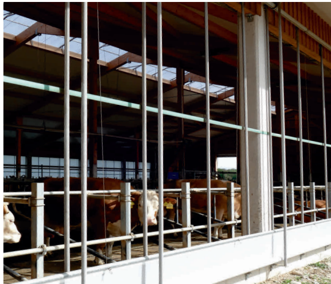
Doppelseitige Abspanner zur Windaussteifung
