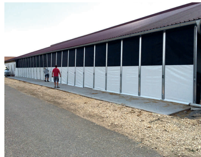
Flexible 2-teilige Schiebelösung zum Schutz der Kälberglus
