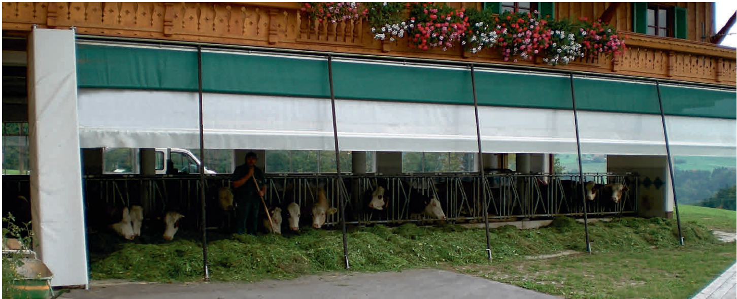
Windschutz Anlage System A mit Mittelwicklung in Plane transparent und grün im Unterbau eines Bauernhofes
