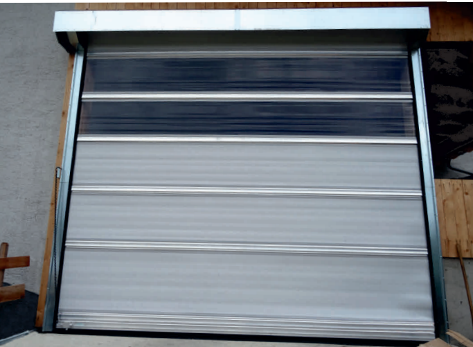
Zwei Klarsichtsektionen oben lassen Licht in die Stalleinfahrt
