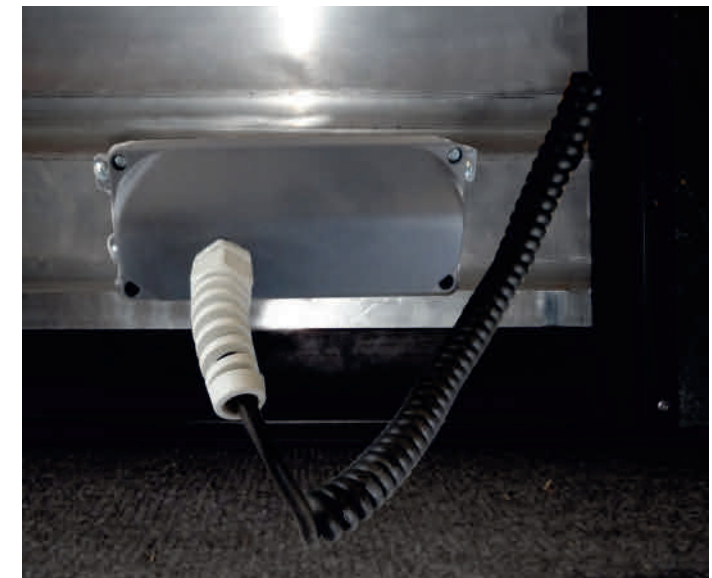
Schließkantensicherung mit Spiralkabel
