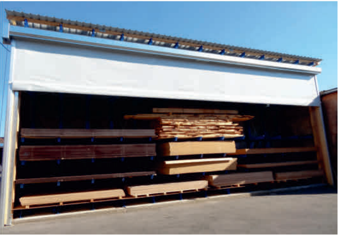
Sicherer Wetterschutz eines Kragregallagers im Holzhandel
