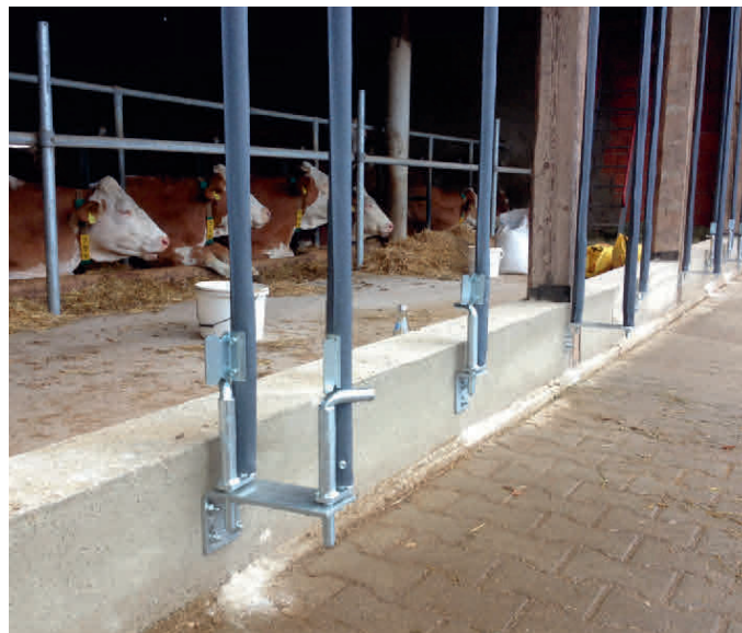
Verschiebbare Aussteifungen ermöglichen Einfahrten
